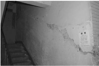
图8 承重墙出现裂缝
