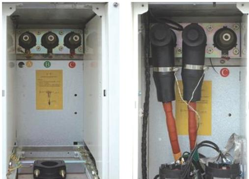
图2 环网柜内部结构
